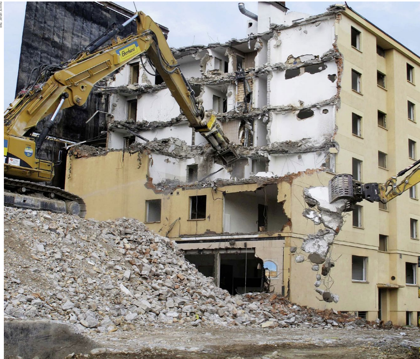
In der Schweiz werden pro Jahr bis zu 4000 Gebäude abgerissen. Zu viel, findet der Verein «Countdown 2030». Im Bild: Abriss eines Gebäudes an der Wehntalerstrasse in Zürich.
